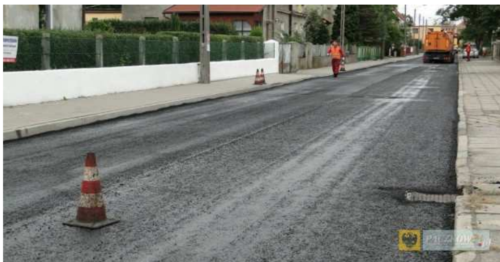
Fot. 3.1. Remont ul. Mickiewicza w Paczkowie
