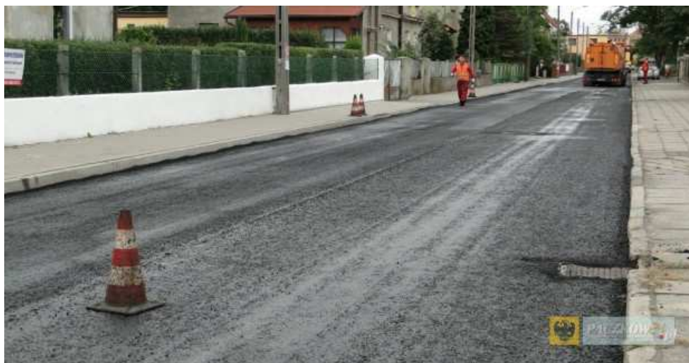
Fot. 3.1. Remont ul. Mickiewicza w Paczkowie
